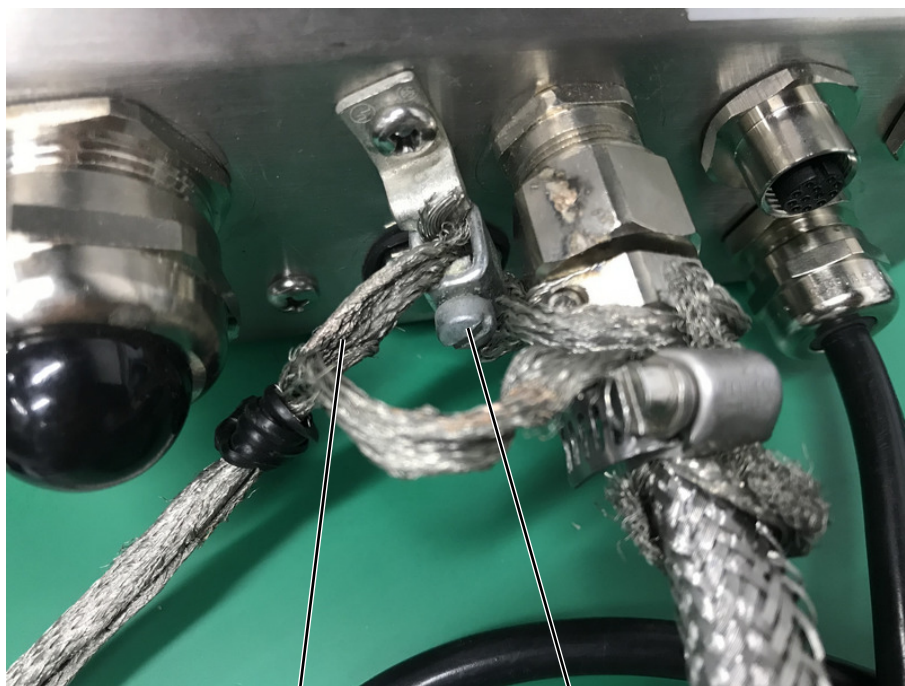
Cable de drenaje exterior
